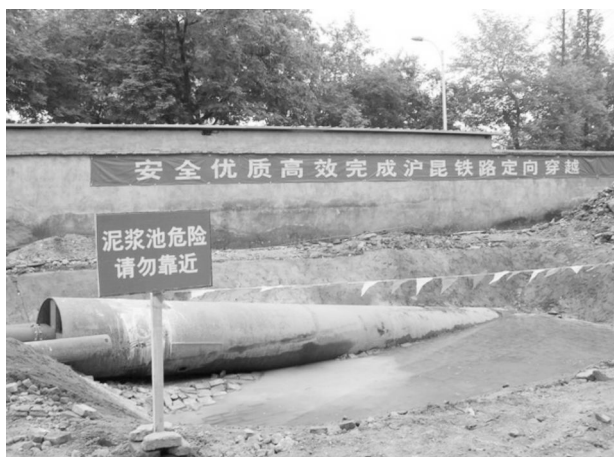
图2 采用夯管技术解决入土段的软硬交互复杂地层成孔曲线满足设计要求,在回拖管线阶段极易造成卡钻。
