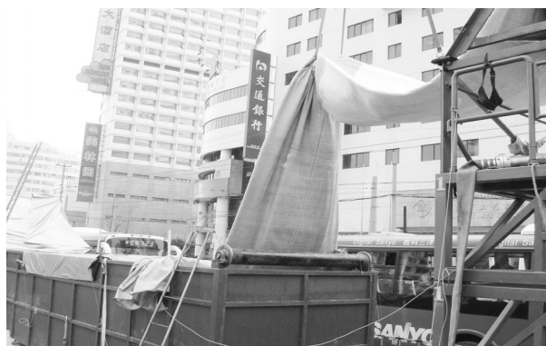
图 4 上海四平路 DN1500 内翻管道转修复技术
