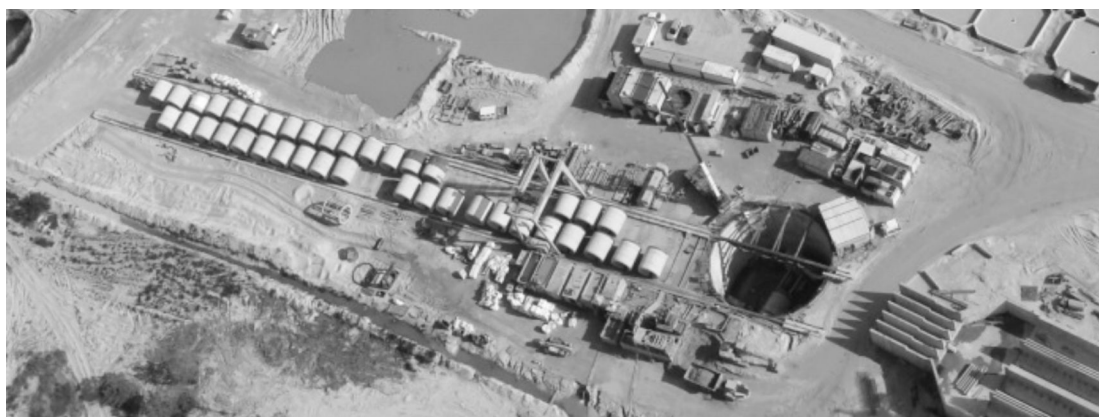
图 7 微型隧道设备安装
