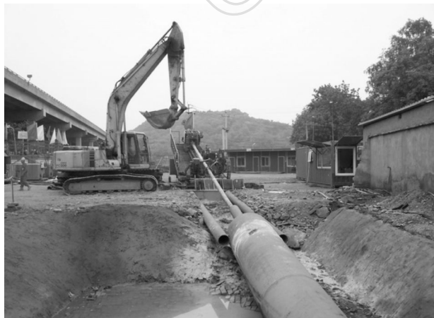
图3 导向施工过程
