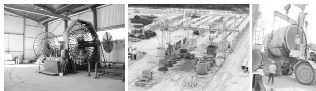
图 5 管道制造现场
